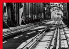
Construção de estradas e pontes
