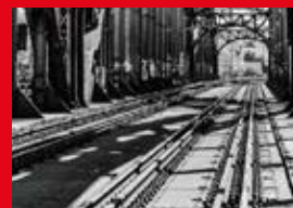
Construção de estradas e pontes
